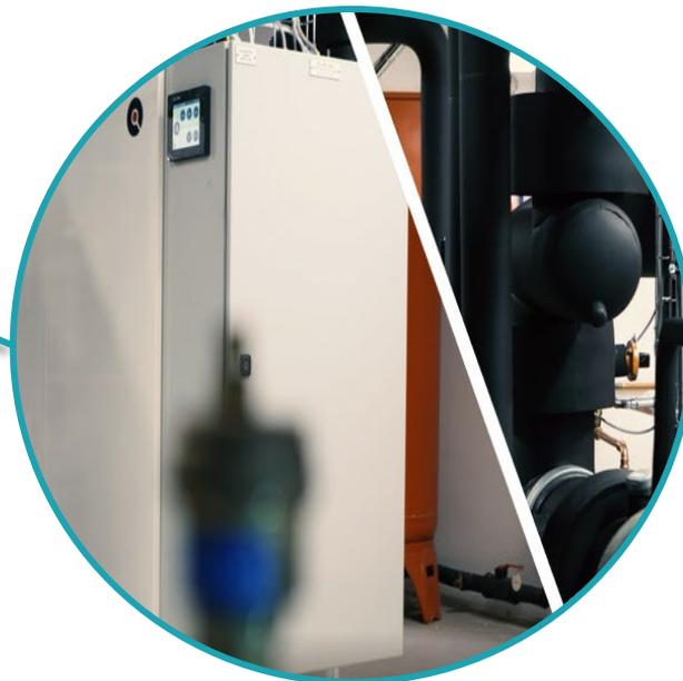
Les **pompes à chaleur** réversibles décentralisées, ajustent la température de distribution du chauffage, de l'eau chaude sanitaire et du rafraîchissement.
